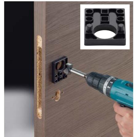
Percement avec une mèche à bois (diamètre 28 mm), et à l'aide du gabarit de perçement HOPPE pour ressort de rappel pour rosaces plates.
