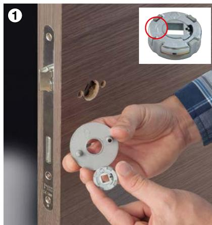
Prendre garde au sens du ressort de rappel lors du clipsage (la flèche indique le sens de fonctionnement de la poignée)
