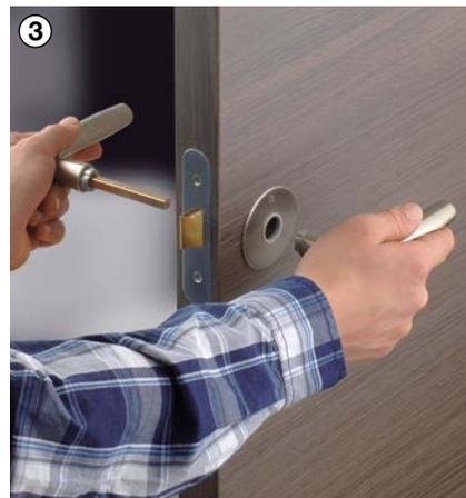
3 Insérer les poignées et assembler – tout simplement ! (si nécessaire, placer les rosaces de clé)
