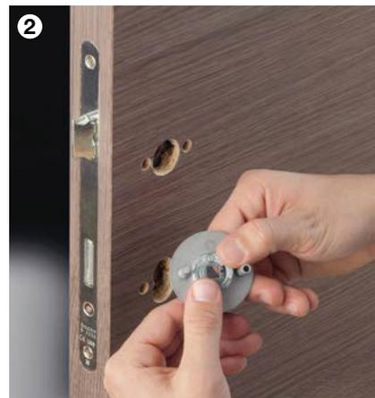
Rückholfeder auf der Rückseite der Griffrosette eingeklipsen
