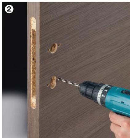
2 Führungsbohrungen für Stütznocken einbringen (für diesen Arbeitsgang das Schloss entfernen)
