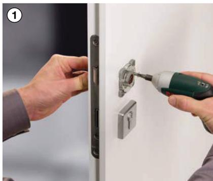
1 Unterkonstruktion aufstecken und festschrauben
