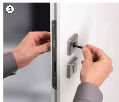
Placer le carré profilé à lamelle
