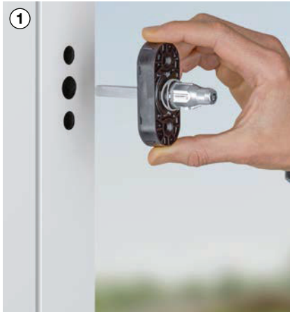
1 Installer la sous-embase sur le profil
