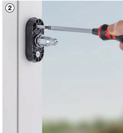
2 Visser la sous-embase sur le profil
